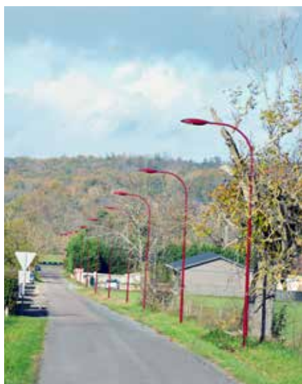
Lampadaires allée de Lamaze, mise en service le 15/09/2019
