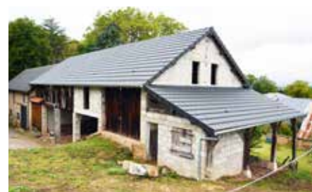
Toiture ateliers municipaux
