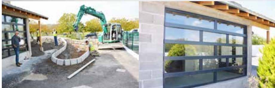
Travaux salle des fêtes
