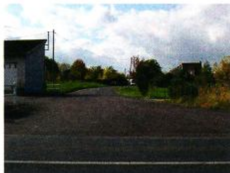
Travaux de sécurité VC Momplaisir
